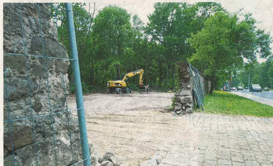
Der Mauerdurchbruch an der Bautzener Straße wird später durch ein Tor ersetzt. Hier schütten Arbeiter den Kies für den neuen Parkplatz auf. Fotos (2): Sebastian Kahnert
