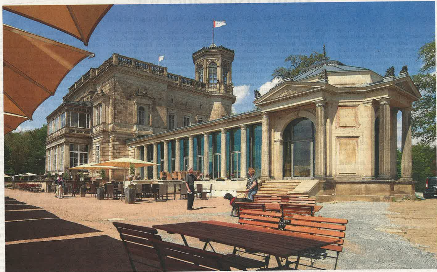
Innen noch eine Baustelle: Wie von Karl August Lingner gewünscht, hat sein Schloss nun endlich auch ein öffentlich zugängliches Restaurant. Fotos R. Grosser / Förderverein Lingnerschloss
