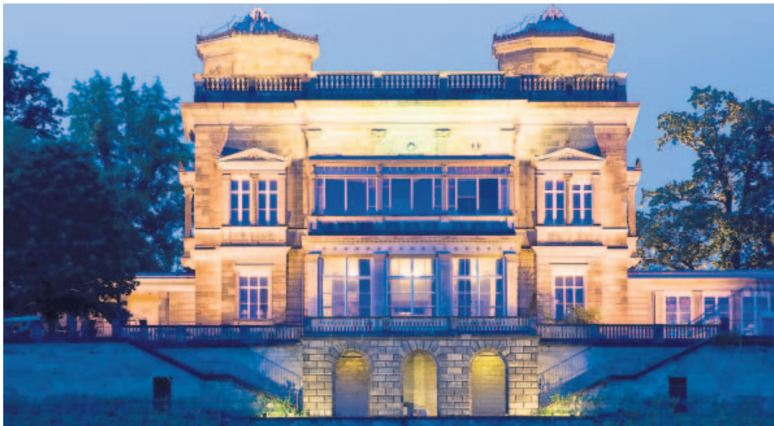
Aus seinem Dämmer Schlaf ist das Lingnerschloss längst erwacht. Seit Jahren wird das Anwesen behutsam schrittweise saniert.
