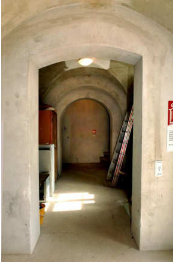
8.1 Rohrrahmtür zum Haupttreppenhaus mit Oberlicht 3.610 €
