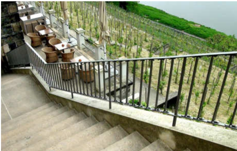
2.2 Treppengeländer zur Weinbergterrasse 2x je 7.200 €
